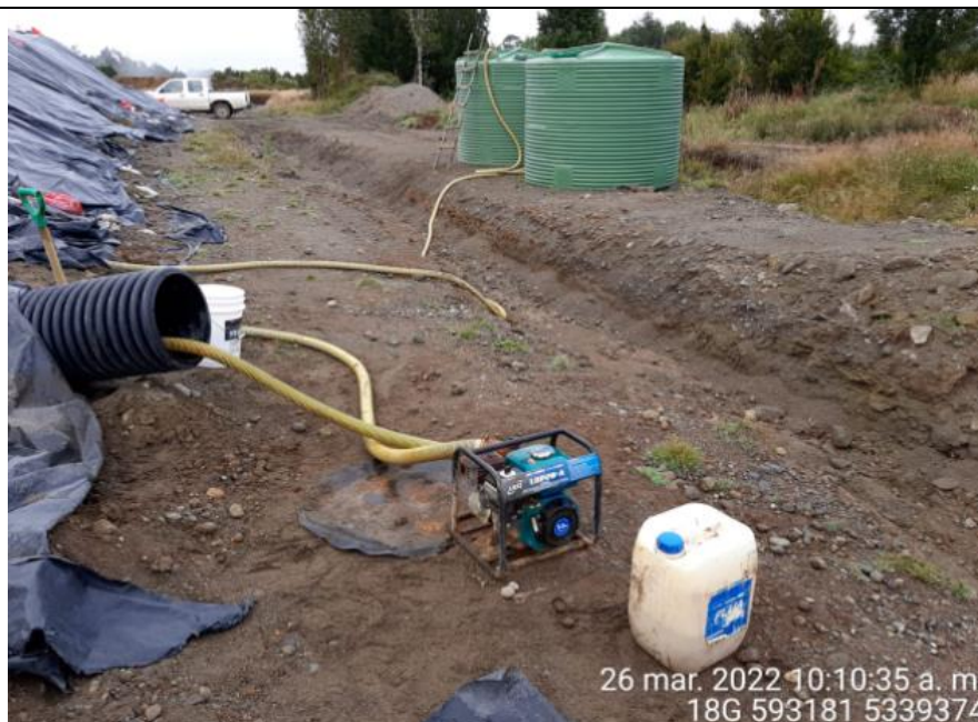
Fotografía N°15: Extracción de Lixiviados D02 por personal municipal. Tomada: Sábado 26 de Marzo del 2022
