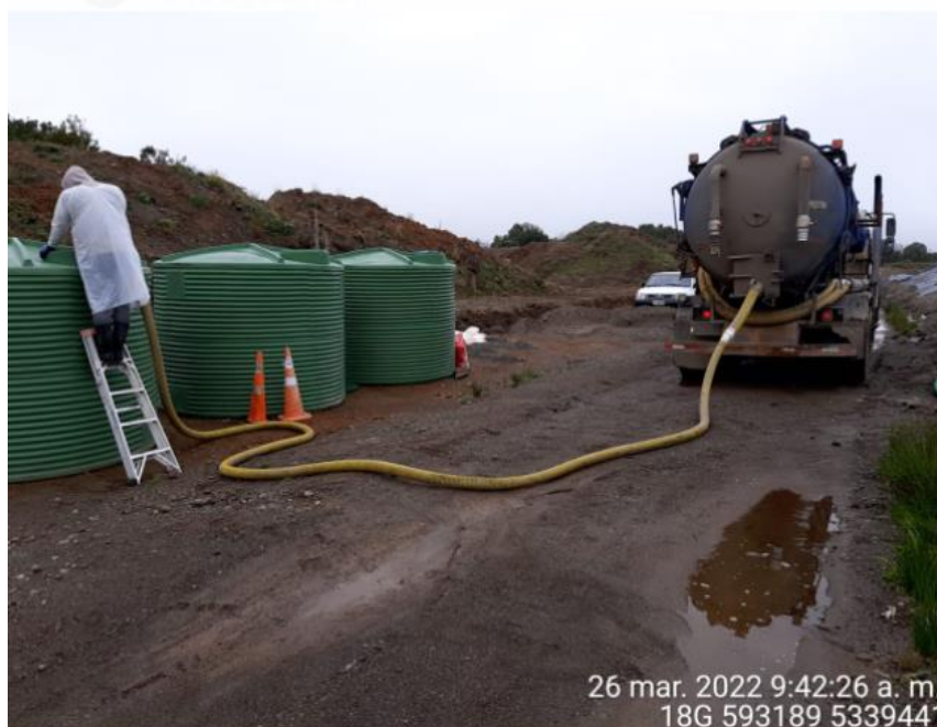
Fotografía N°18: Retiro de Lixiviados desde estanques por empresa Tresol. Tomada: Sábado 26 de Marzo del 2022
