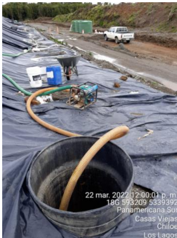
Fotografía N°5: Extracción de Lixiviados C12, C13 y C14 por personal municipal. Tomada: Martes 22 de Marzo del 2022.
