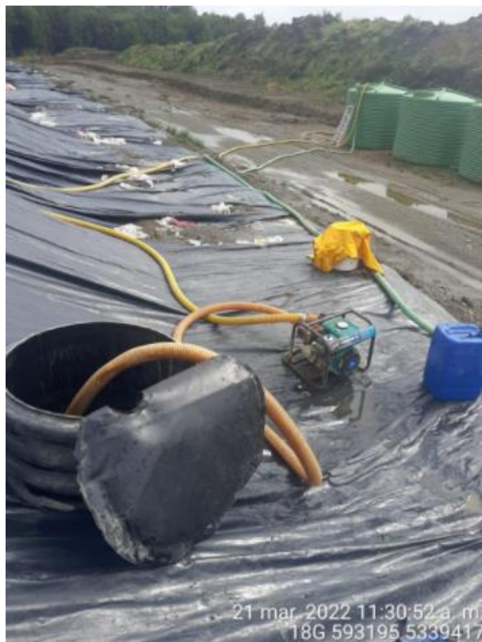
Fotografía N°1: Extracción de Lixiviados desde cámaras C12 y C13 por personal municipal. Tomada: Lunes 21 de Marzo del 2022.
