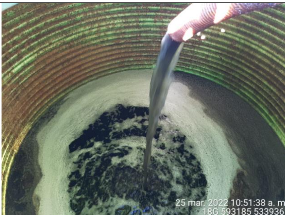
Fotografía N°14: Extracción de Lixiviados a estanque por personal municipal Tomada: Viernes 25 de Marzo del 2022.
