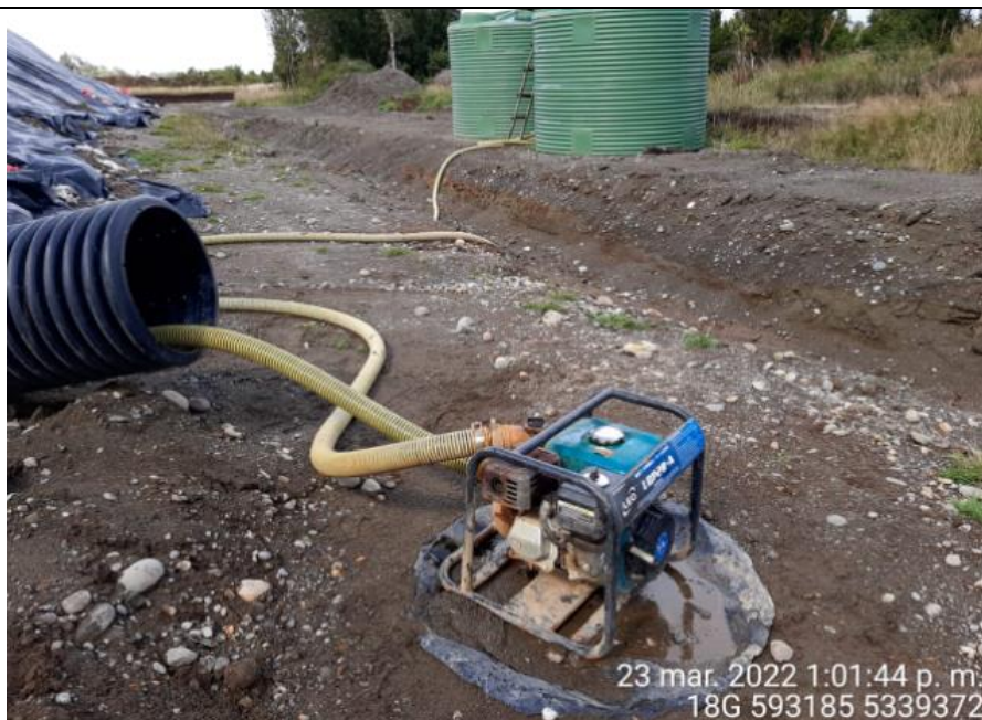
Fotografía N°9: Extracción de Lixiviados diagonal D02 por personal municipal. Tomada: Miércoles 23 de Marzo del 2022.
