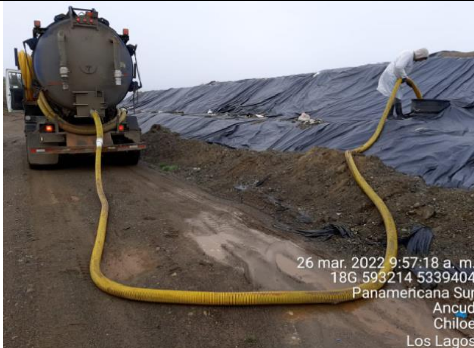
Fotografía N°17: Retiro de Lixiviados desde cámaras por empresa Tresol. Tomada: Sábado 26 de Marzo del 2022
