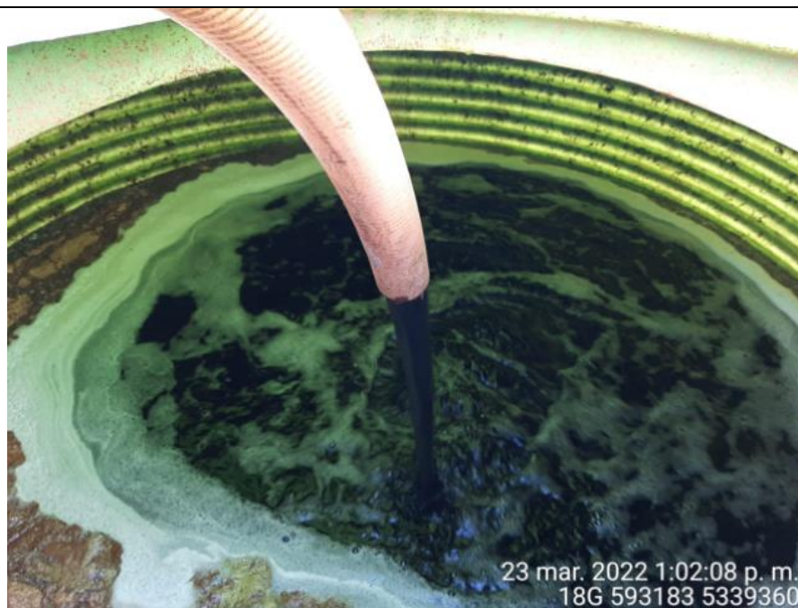
Fotografía N°10: Extracción de Lixiviados a estanque. Tomada: Miércoles 23 de Marzo del 2022.
