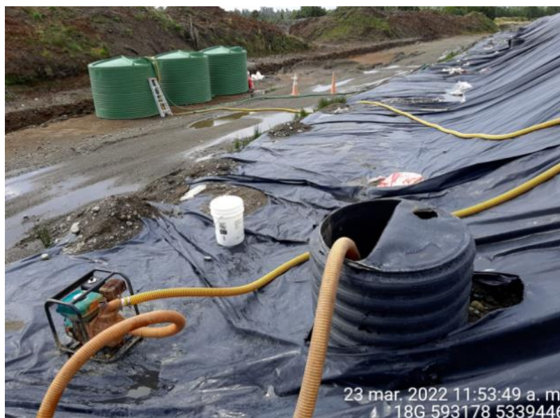
Fotografía N°8: Extracción de Lixiviados C12, C13 y C14 por personal municipal. Tomada: Miércoles 23 de Marzo del 2022.
