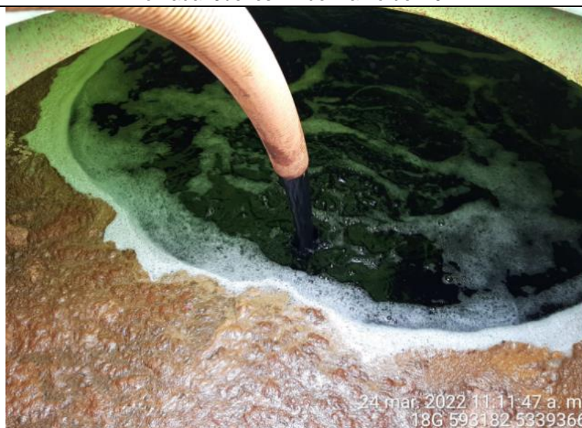
Fotografía N°12: Extracción de Lixiviados a estanque por personal municipal. Tomada: Jueves 24 de Marzo del 2022
