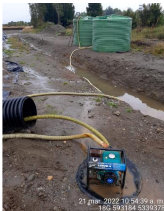
Fotografía N°3: Extracción de Lixiviados desde cámara C03. Tomada: Lunes 21 de Marzo del 2022.
