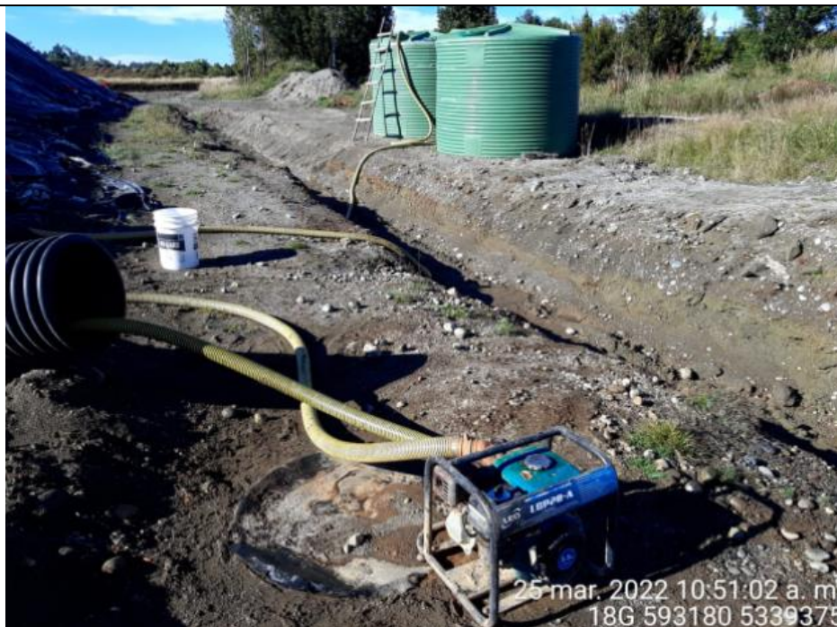
Fotografía N°13: Extracción de Lixiviados desde diagonal D02 por personal municipal Tomada: Viernes 25 de Marzo del 2022.
