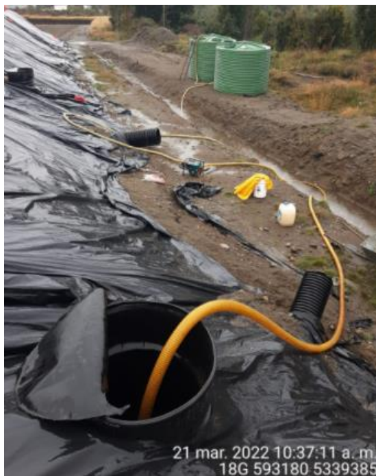
Fotografía N°2: Extracción de Lixiviados desde cámara C03. Tomada: Lunes 21 de Marzo del 2022.
