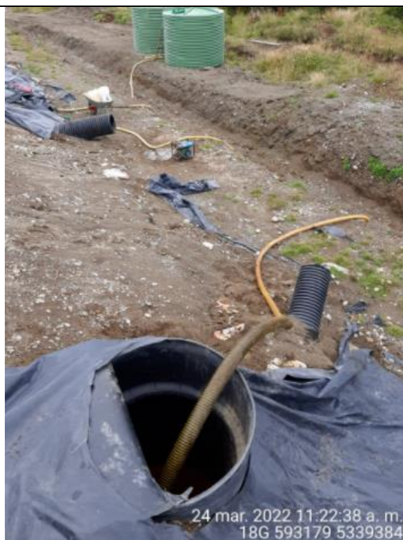
Fotografía N°11: Extracción de Lixiviados C03 por personal municipal. Tomada: Jueves 24 de Marzo del 2022
